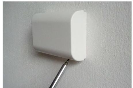
**Schritt 2:** Legen Sie die Gehäuseunterseite möglichst gerade an der Wand an, um eine Bohrschablone zu erhalten. Bohren Sie die Löcher.
