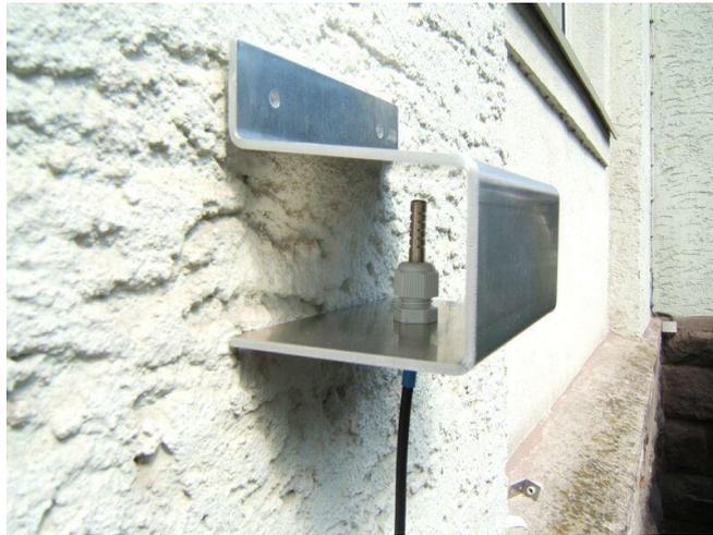
Das Schutzblech bietet Schutz vor Regen und vor allem vor Wasser, welches mit der Hauswand Kontakt hatte. Dieses Wasser kann Spuren von Kalk oder Salzen enthalten, dadurch kann dem Sensor erheblicher Schaden zugefügt werden.
